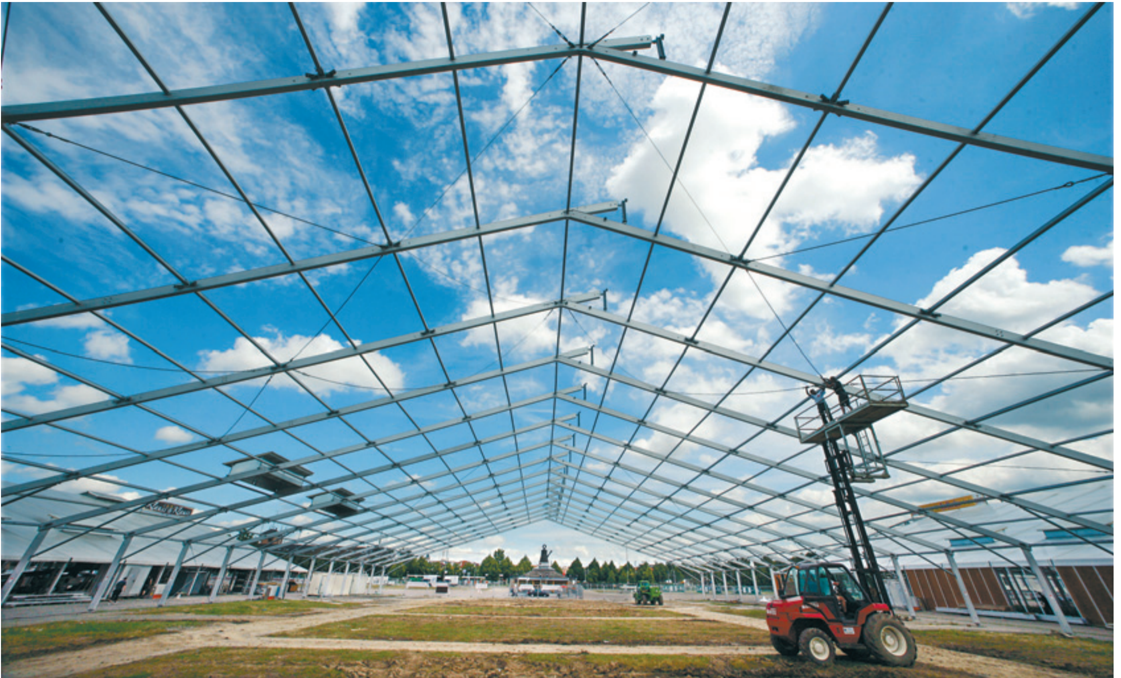
Ende Juli: das Festzeltgerippe streckt sich über den Cannstatter Wasen, Arbeiter stabilisieren die Aluminiumträger mit Stangen und Stahlseilen.
